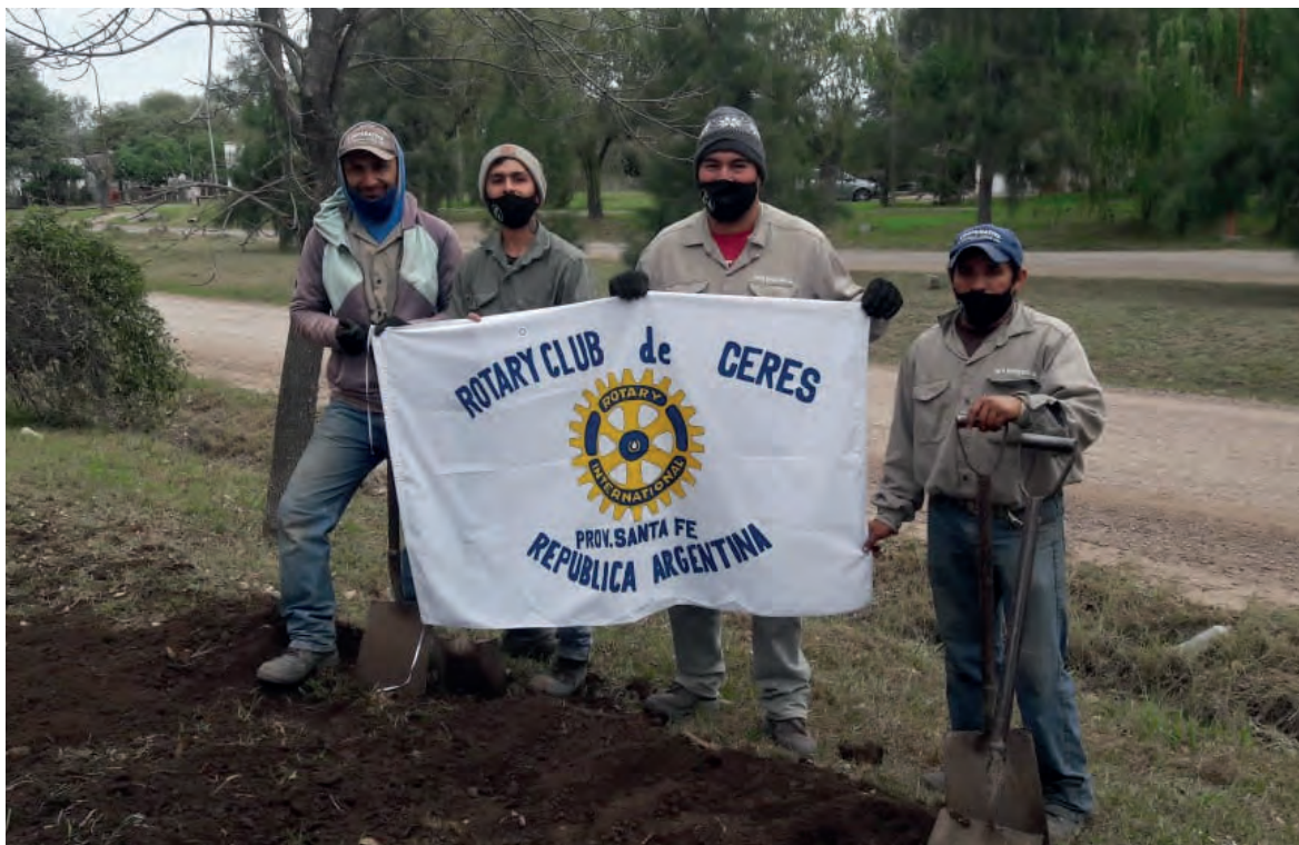
Lavori di posa delle tubazioni
