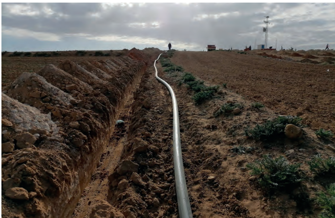
Lavori di posa della tubazione
