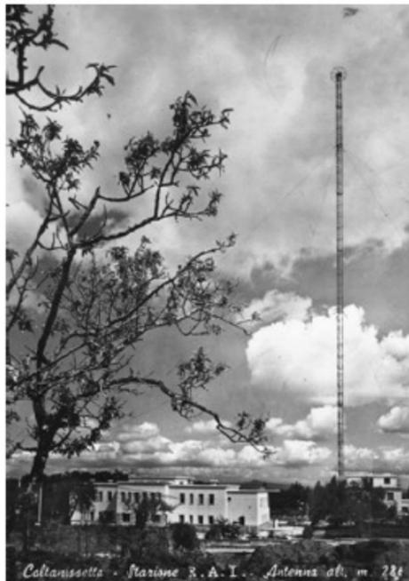
per le onde medie (O.M.) alla frequenza di 567 kHz, e in contemporanea per le onde lunghe (O.L.) su kHz 189, con un sistema originale ed unico di accoppiamento, con i due segnali in relazione armonica (189x3). Una seconda antenna di circa 50 metri, poste nelle vicinanze, assicurava la emissione in onde medie del secondo programma e particolari antenne "a nassa" irradiavano sulle onde corte (O.C.) a 6060 kHz, 7155 KHz e 9515 KHz.
